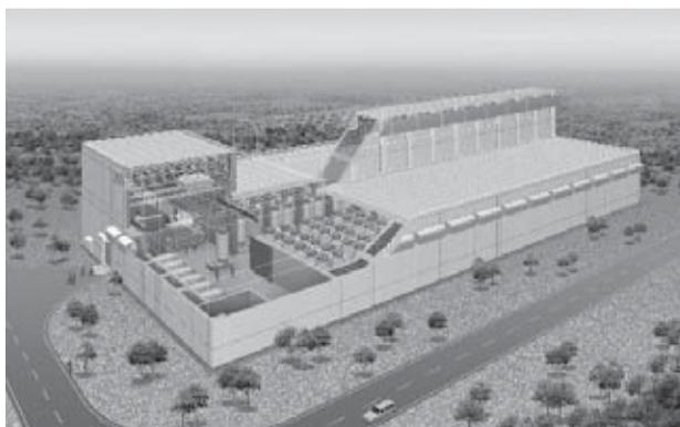
3,000トン貯蔵建屋【約130m×約60m×（高さ）約30m】
