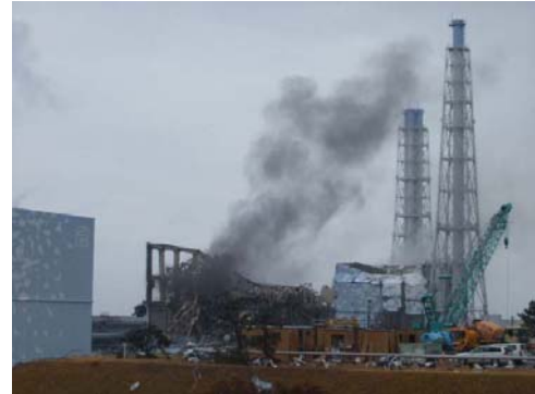
爆発後の3号機の外観
