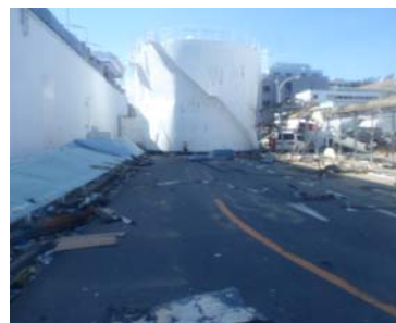
津波で流されたタンク
