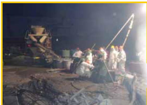
凝固剤注入による止水（2号機）
