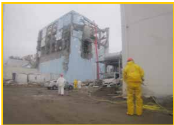
コンクリートポンプ車による放水作業の様子
