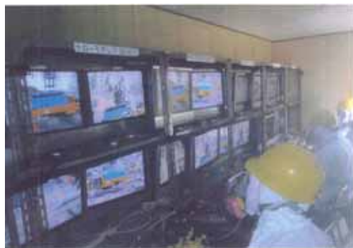
遠隔操作による瓦礫撤去
