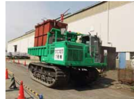
遠隔操作のクローラードンプ
