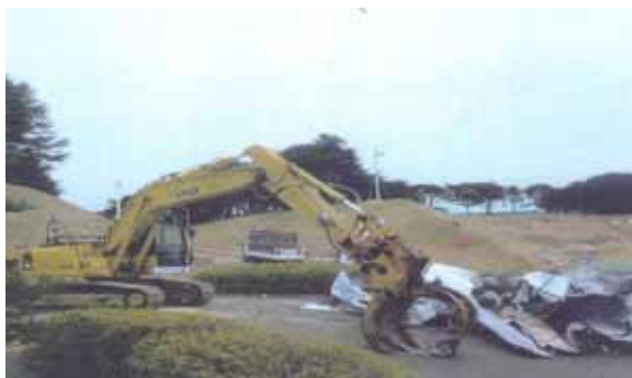
アイアンフォークにより瓦礫をコンテナに積込
