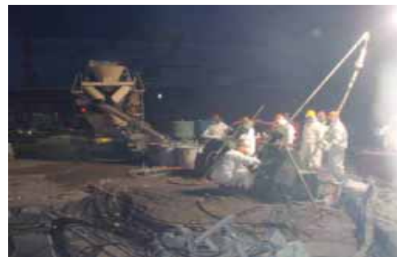
凝固剤注入による止水対策（2号機）
