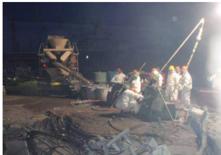
凝固剤注入による止水対策
