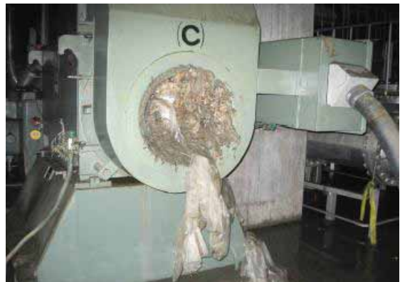
〔原子炉建屋及び非常用ディーゼル発電機の被害状況(1号機)〕
