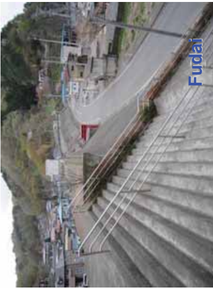
〔太田部地区の15.5m防潮堤の健全性〕
