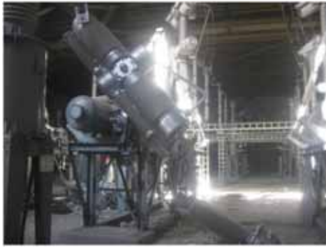
撮影：東京電力株式会社 H23.3.23
