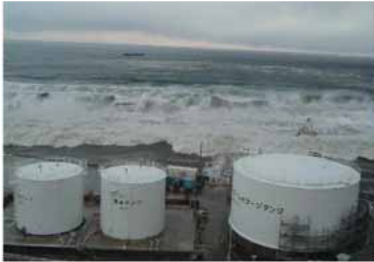
【福島第1原発 津波来襲状況 2011年3月11日 固体廃棄物貯蔵庫東側のり面(5号機の近傍)から東側を撮影】=東京電力提供
