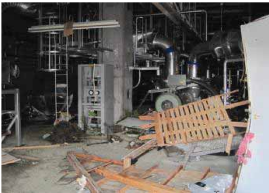
〔原子炉建屋及び非常用ディーゼル発電機の被害状況(1号機)〕
