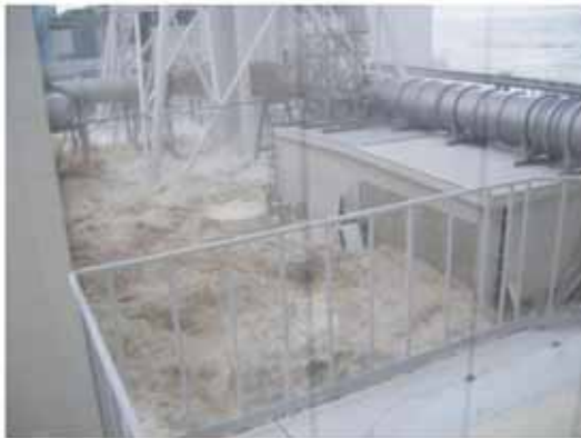
【福島第1原発への津波来襲状況 2011年3月11日 廃棄物処理棟4階から北側を撮影】午後3時43分ごろ(2)=東京電力提供
