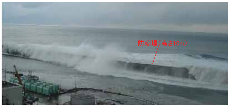
【福島第1原発 津波来襲状況 2011年3月11日 固体廃棄物貯蔵庫東側のり面(5号機の近傍)から南側から東側を撮影】=東京電力提供
