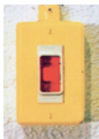
非常停止ボタン このボタンを押すと加速器の運転を阻止することができます。
