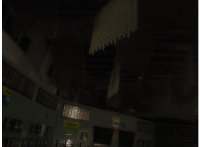
写真2 1,2号機中央制御室の状況
