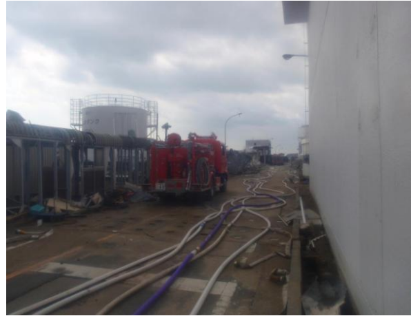
写真6 1,2号機防護管理ゲート前から 3号機方面の状況
