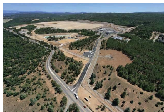
ITER 建設の様子
