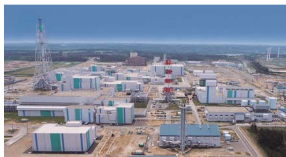
図3-19 日本原燃（株） 六ヶ所再処理施設
