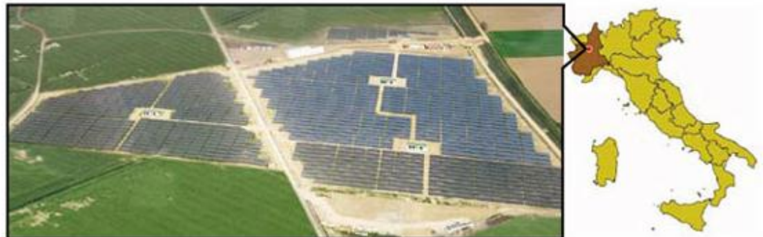
京セラ製太陽電池が供給されたイタリアの太陽光発電施設 (ピエモンテ州・チリアーノ)
