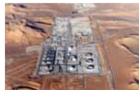
原油生産プラント(アルジェリア)
