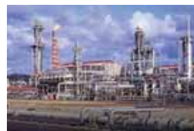
LNGプラント(マレーシア)
